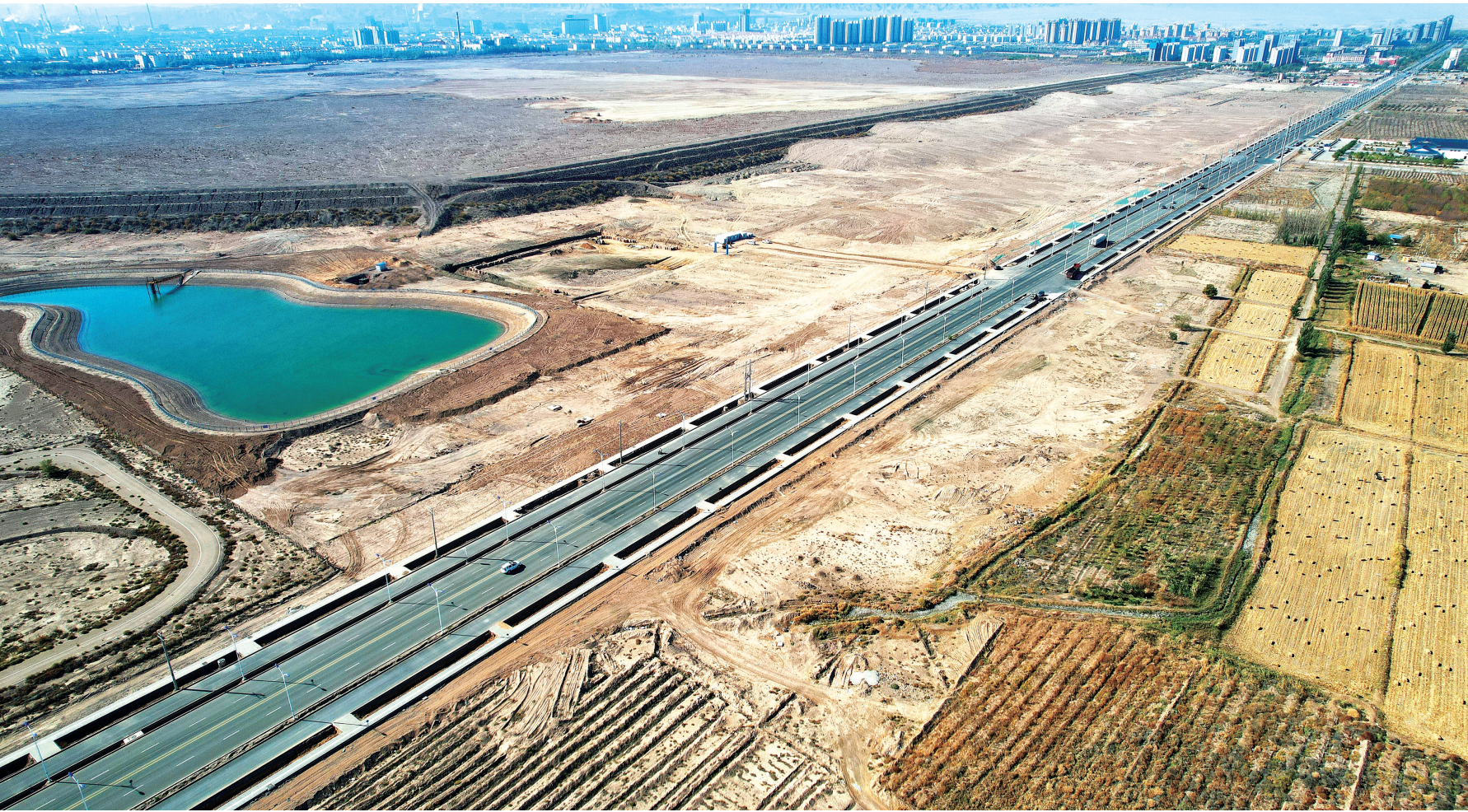
重庆路是我市一条东西走向的重要公路,近年来,随着车流量的逐渐加大,无非机动车道和行人路面,已严重影响道路安全,为有效解决存在的安全隐患,此路段在机动车道两侧加修非机动车道和人行道,目前正在加紧施工。图为重庆路全景。记者 张宏斌 摄
