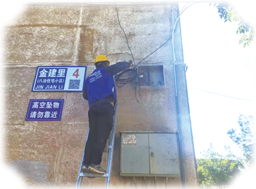
图为中国移动金昌分公司施工人员正在整理“蜘蛛网”。
